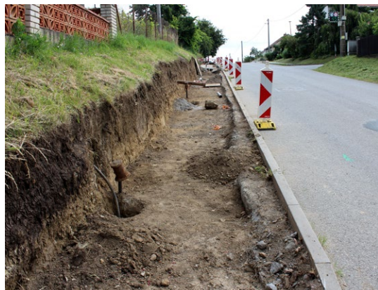
^ Stavba chodníku od točny
