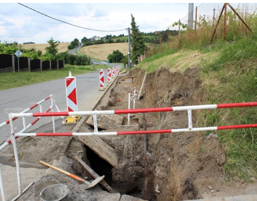
^ Stavba chodníku od točny
