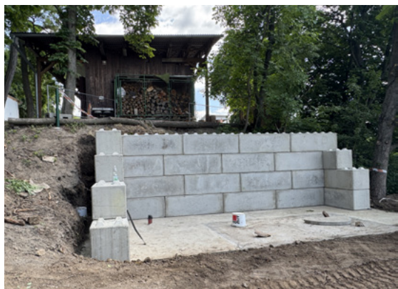
➤ Budování sociálního zařízení na hřišti Pod lesem
