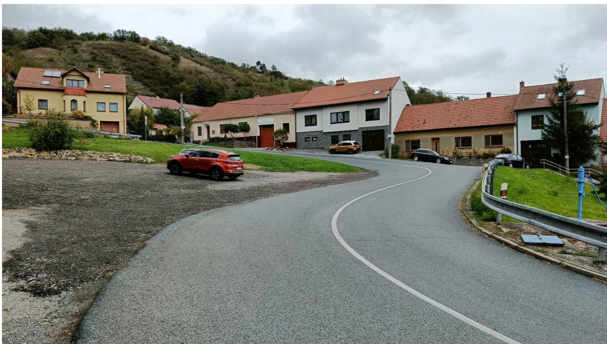
Obr. 4: Úsek průjezdního úseku silnice III/3834 s chybějící infrastrukturou pro chodce.
