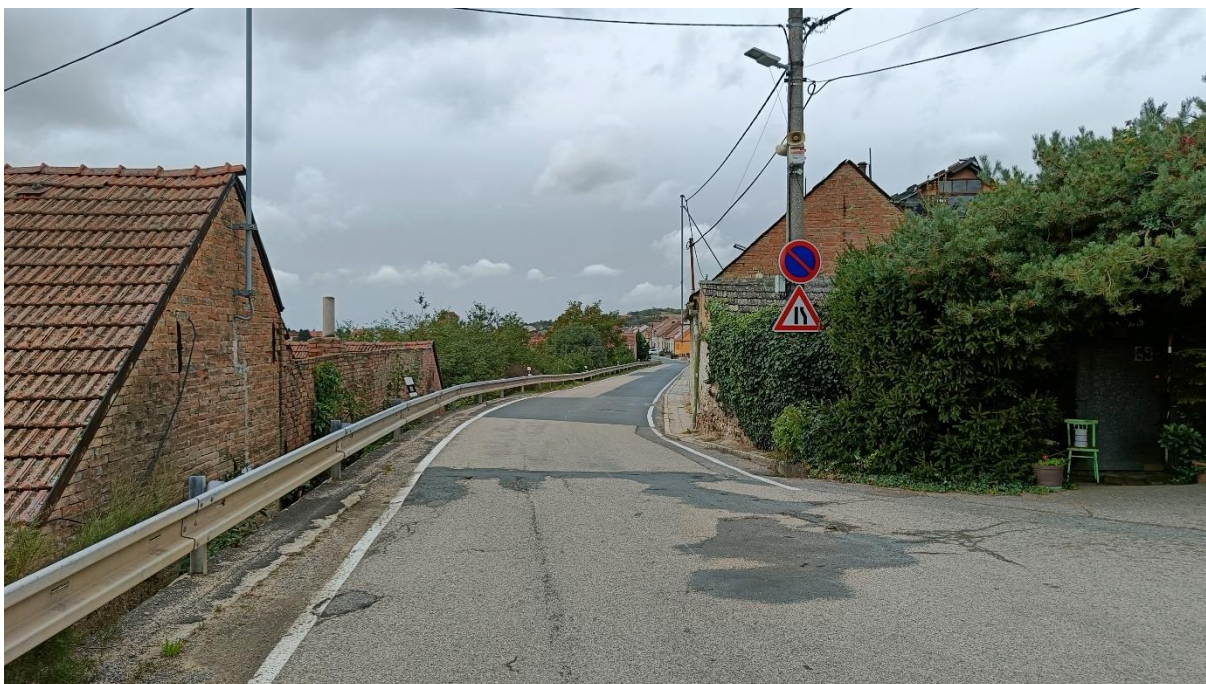
Obr. 9: Zúžený úsek silnice III/3834 s chybějícím chodníkem – v blízkosti zastávky Hradská.
