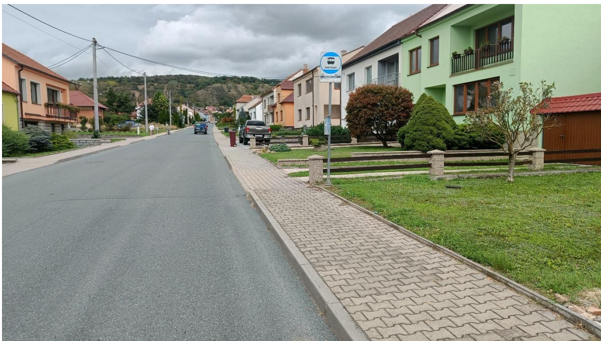
Obr. 5: Zastávka autobusové dopavy s chodníkovým nástupištěm bez hmatových prvků pro nevidomé a slabozraké.
