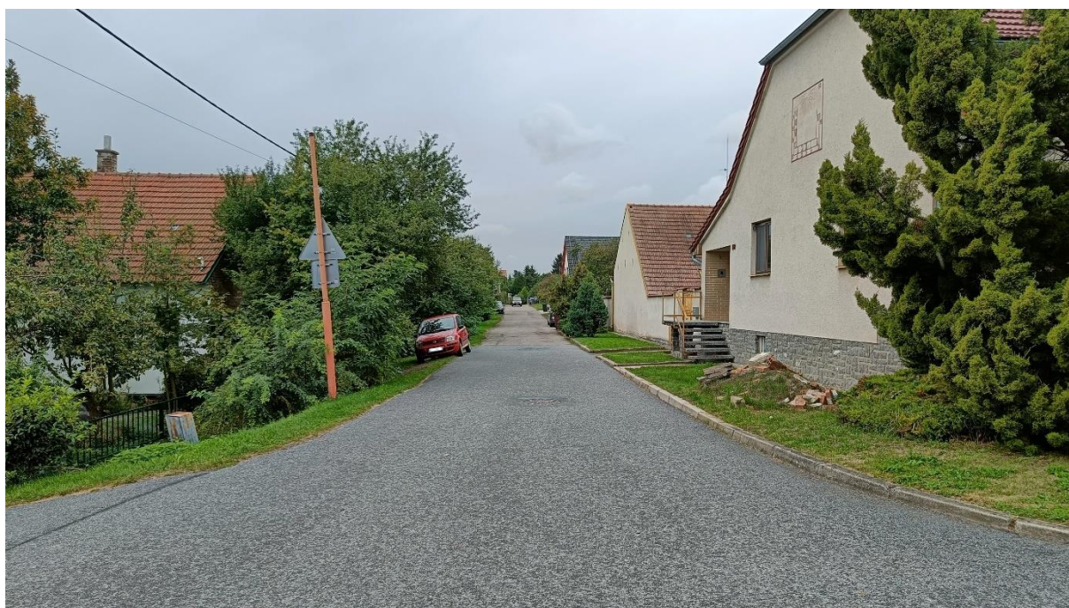
Obr. 14: Místní komunikace v intravilánu obce s šířkou vozovky, která neumožňuje parkování vozidel.
