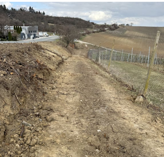
^ Obnovená polní cesta na Vítovce
