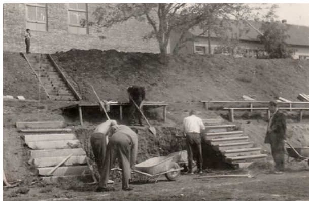
Budování tribuny u sokolovny
