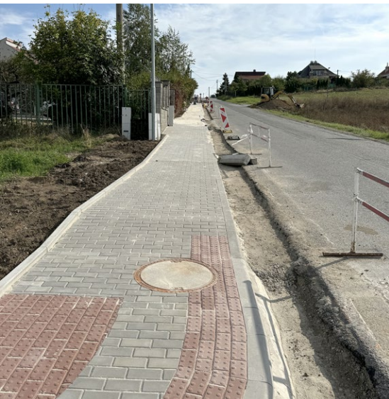
^ Stavba chodníku od točny
